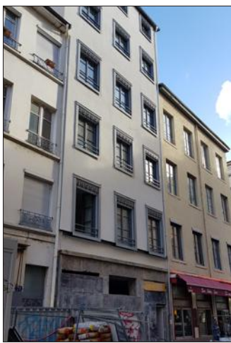
L'immeuble situé rue Montesquieu a été entièrement rénové. Photo Progrès/Aline DURET
